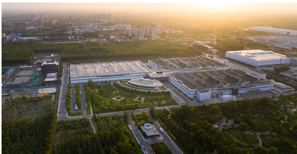
中国河北华为廊坊云数据中心
